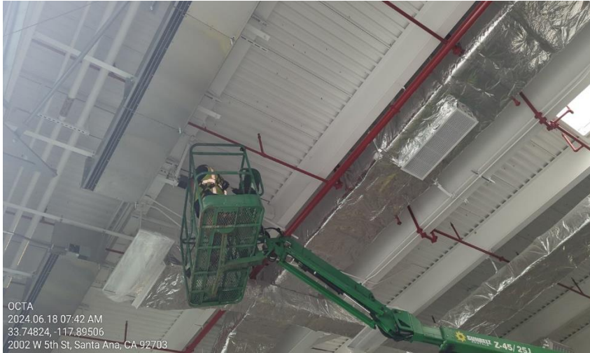
Interconnect conduits installation
